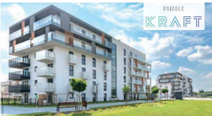
ŁÓDŹ | PL OSIEDLE KRAFT (2. BAUABSCHNITT)
